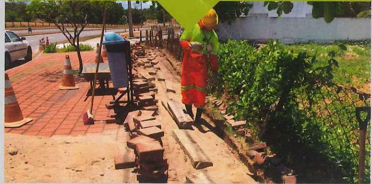
Realizamos a desobstrução das pontas de ala e campos de escoamentos devido as constantes chuvas, que podem ocasionar assoreamento dos sistemas de drenagem. A desobstrução e a limpeza/capina são intercaladas, onde uma semana é realizada a desobstrução e na outra a limpeza/capina.
