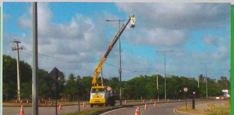
No dia 19/12, realizamos a manutenção da iluminação viária visando corrigir problemas como: luminárias apagadas durante a noite ou acessas durante o dia. Conseguimos corrigir um total de 10 luminárias, melhorando o conforto e segurança dos usuários à noite e economizando energia com luminárias acessas em horários indevidos.
